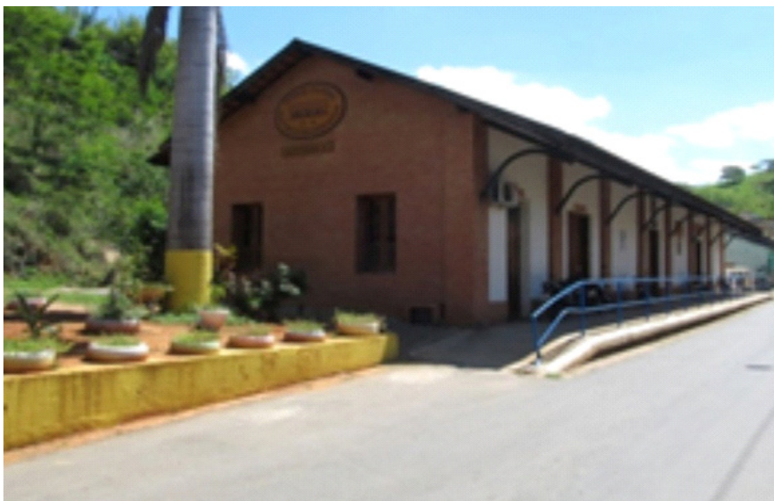
Figura 10: Estação Ferroviária de Natividade 2018
