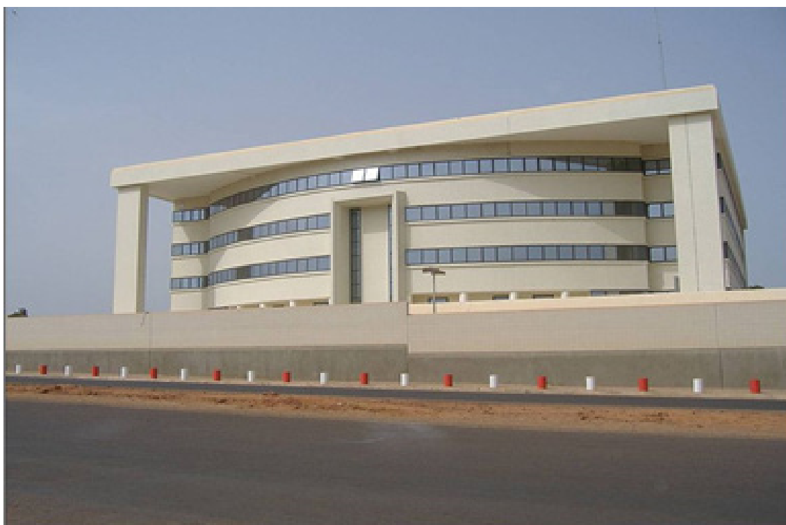
Figura 9: Edifício do Banco Nacional da Guine Bissau. Todo climatizado e com fortes problemas de temperatura ambiente devido a escassez de energia
